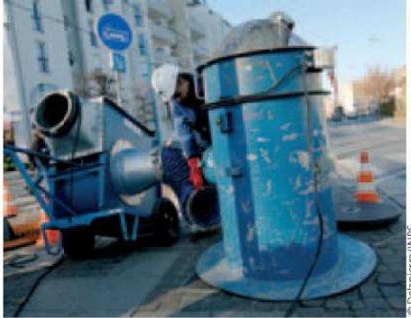
Mise en place d'une ventilation forcée sur une des ouvertures d'accès
